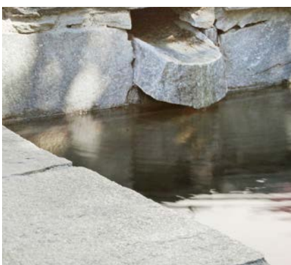
Mit Natursteinarbeiten wird das traditionelle Handwerk gepflegt.
