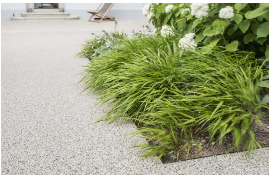
↑ Naturkies bildet in Verbindung mit einer speziellen Kunstharzmischung einen homogenen Wegbelag. (Foto: Gemfloor)
